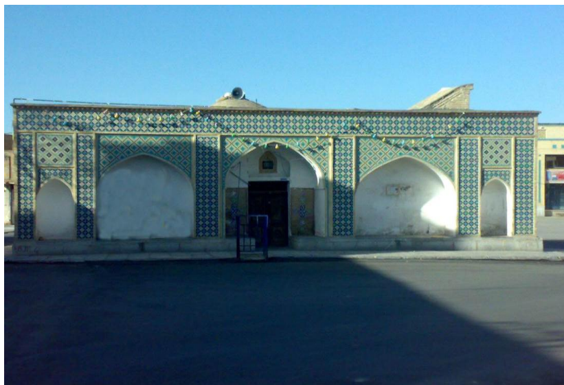
شکل ۵. نمای ورودی شبستان مسجد اتابکان
